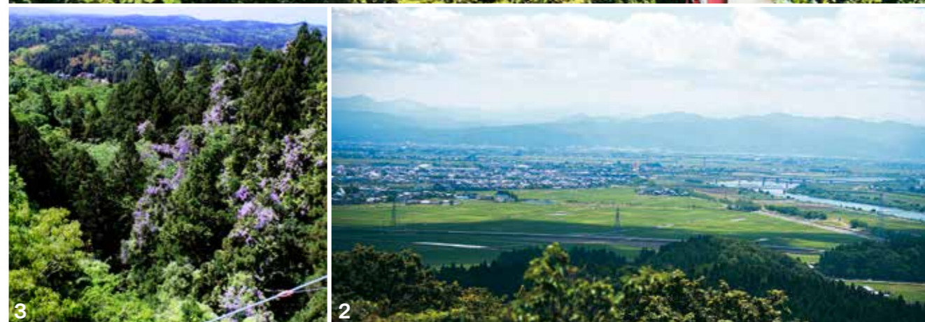
1 千眼堂吊り橋は新緑の季節も素晴らしいが、紅葉の秋や雪降る冬もまた違った表情を見せてくれる。「新潟の橋50選」に選出 2 朝日山展望台からの眺め。天気が良い日は粟ヶ岳、守門岳、越後駒ヶ岳、中ノ岳、八海山、巻機山、谷川連峰、苗場山が青々と広がる様が見られる 3 吊り橋からは寺泊方面が見渡せる。5月は新緑の中に紫色のフジの花も見られる
