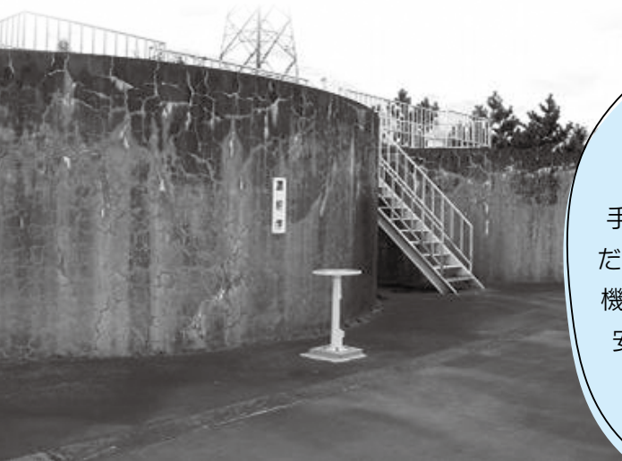
老朽化した吉田浄水場の濃縮槽
