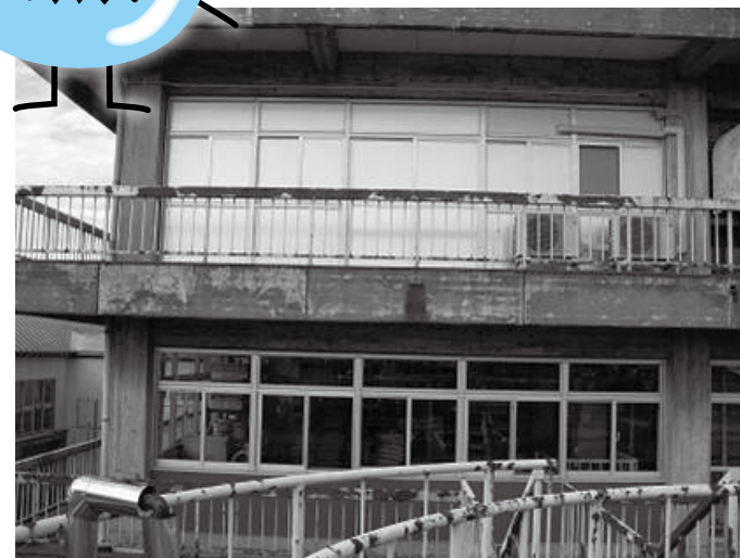
老朽化した道金浄水場の構造体
