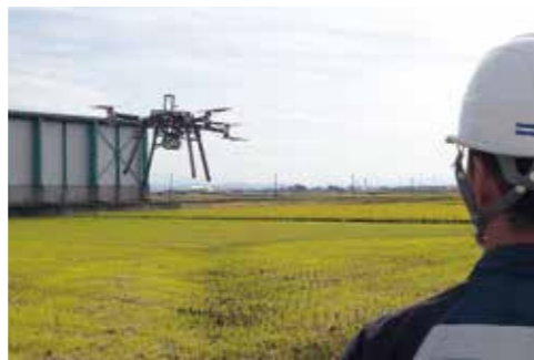
●11月13日 R116号吉田バイパス 測量作業を実施 吉田鴻巣地内他
