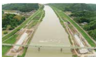
▲渡部橋周辺の河川敷掘削
