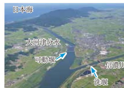
▲通水して以来、越後平野を信濃川の洪水から守っている大河津分水。
