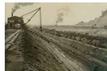
▲斜面を切り崩し、土砂をトロッコに積み込んだ「エキスカベーター」。
