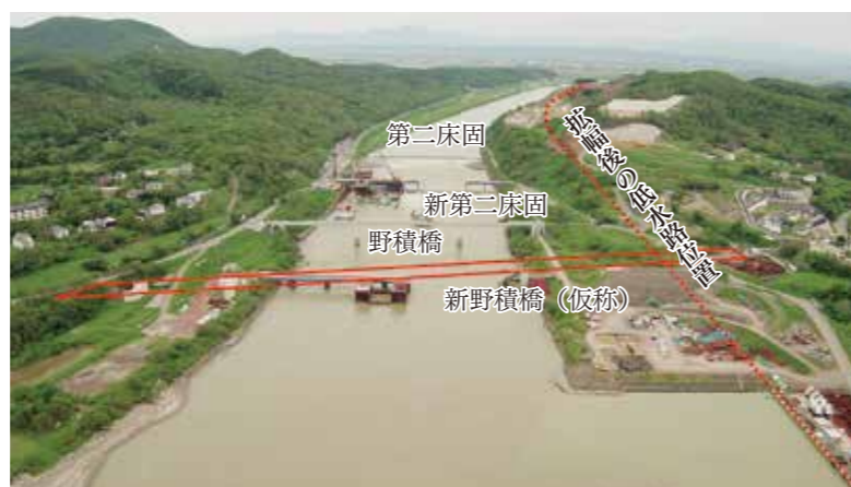
▲「令和の大改修」大河津分水の河口周辺の工事状況
