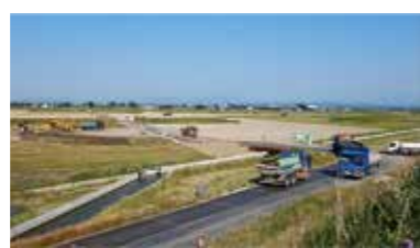
▲山部掘削土を活用したほ場整備 (分水地区)
