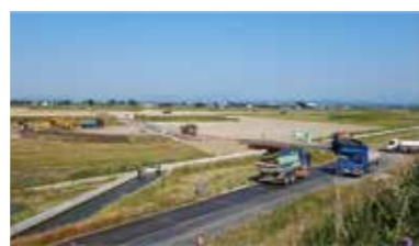
▲山地部掘削土を活用したほ場整備(分水地区)
