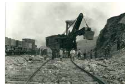
▲イギリス製の岩盤掘削機「スチームナビー」。
