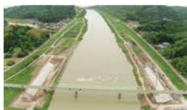
▲渡部橋周辺の河川敷掘削
