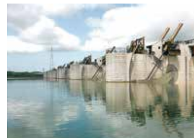
▲右岸側から見た可動堰
