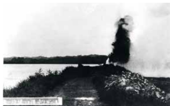
▲通水のための爆破の瞬間
