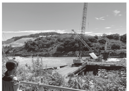
大津分水水路改修事業にともなう山地の堀削や新第二床固の建設の様子
