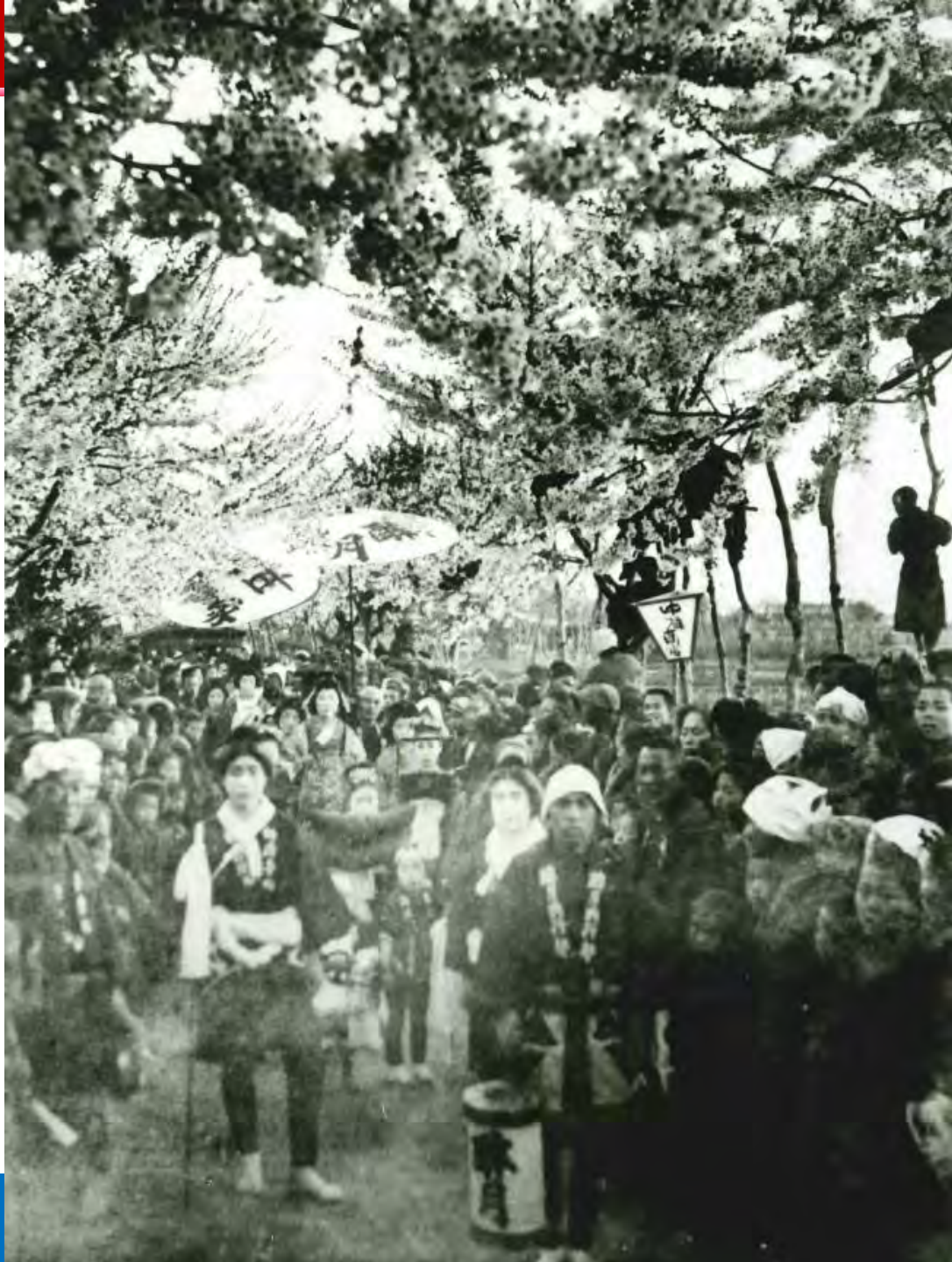
大河津分水路堤防 昭和初期
