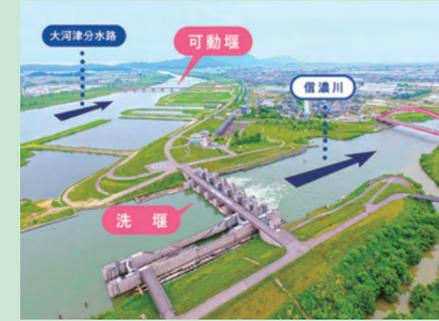
▲水量を可動堰と洗堰でコントロール
