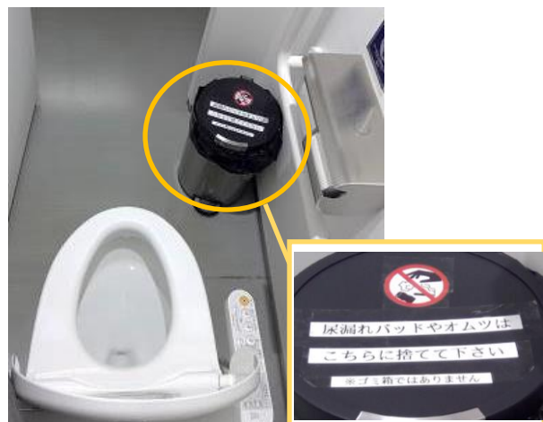
個室のサニタリーボックス設置の様子
