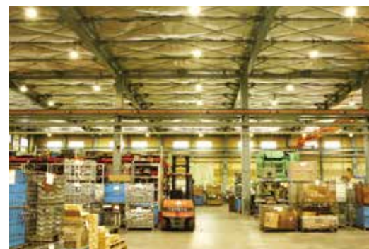
▲導入されたLED照明と遮熱シート
