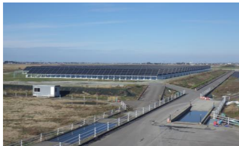
▲クリーンセンター館野メガソーラー発電所
