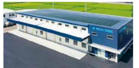
▲屋根の大部分に設置された太陽光パネル。設置後は、電力コストの削減のほか、工場内の気温上昇を抑える点でも効果があったといえます。
