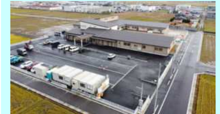
△調整池【地域生活基盤整備】
