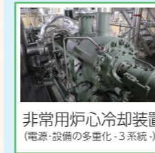
+ 高圧代替注水ポンプ (制御電源不要)
