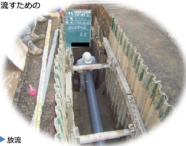
下水道管を布設している写真です。
