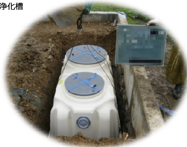
合併処理浄化槽を設置している写真です。
