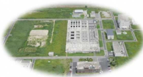
新潟県西川浄化センター
