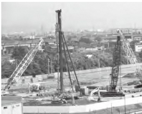
造成が終わり建設工事が始まった県央基幹病院
