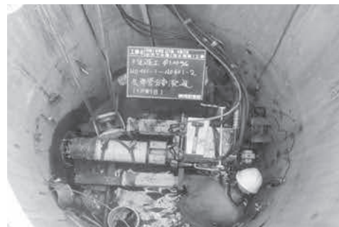
引き続き下水道管の定期的な点検や路面巡視などを実施し、市民が安全に安心して暮らせるように努めてほしい
