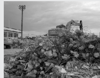
解体工事が始まった燕南小学校
