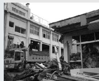
校舎の一部解体が始まった燕中学校
