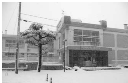
耐震強度不足の燕南幼稚園
