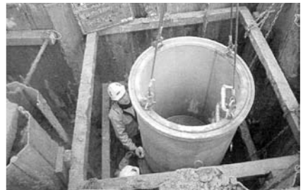
下水道マンホール据付工事
