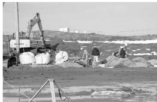
工事が進む新庁舎建設地
