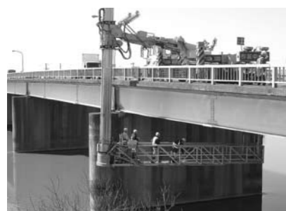
橋梁点検機材を使用した中央橋の点検
