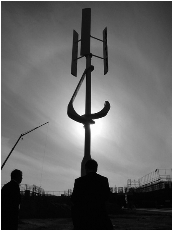
親水公園の照明灯 親水公園には風力と太陽光を利用した 照明灯が5基あります。 蓄えた電力で、公園を照らします
