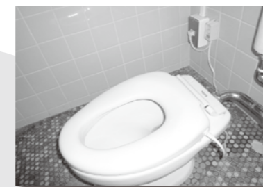
保育園(14園)、幼稚園(4園)のトイレを洋式暖房便座に改修
