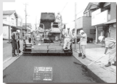
側溝整備や道路の拡幅改良(約30カ所)
