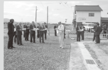
八王寺地内の道路舗装現場
