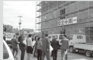
燕南小学校建設現場を視察
