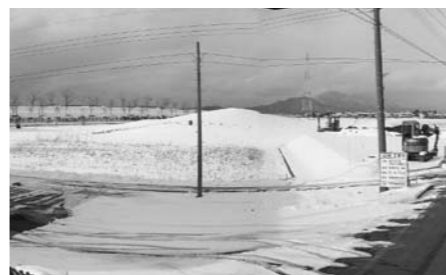
大河津分水さくら公園工事現場
