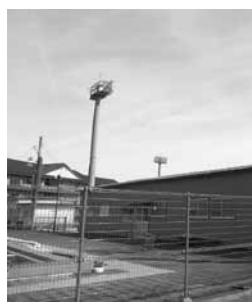
西小学校プールに設置された、折りたたまれた防球ネット。隣接したグラウンドから飛んできたボールを防ぐ。
