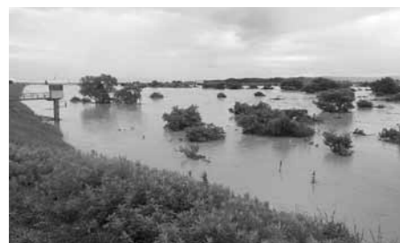
大河津分水路の増水状況(7月30日撮影)
