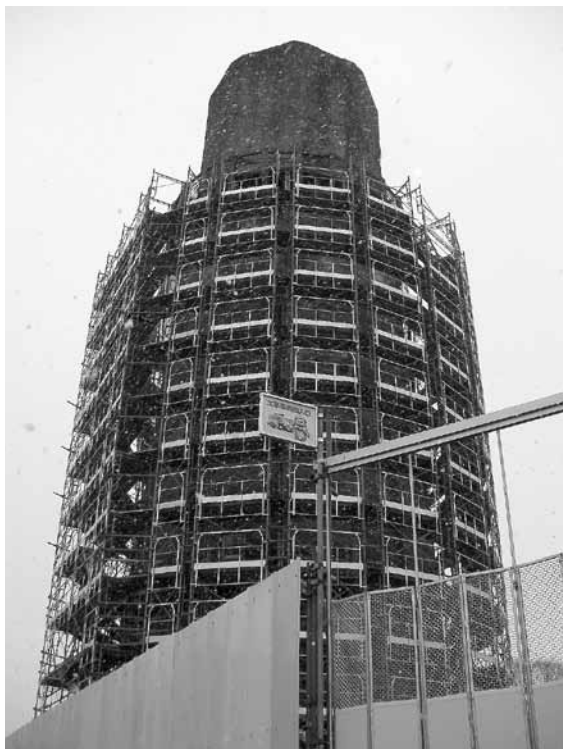
「工事中の旧配水塔」 1938年(昭和13年)に建設され、40年にわたり給水を担いました。その後は燕市のシンボルのひとつとして風景に溶け込んできました。3月には新しい姿をお披露目します。
