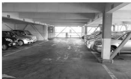
50台以上の月極契約を持つ仲町市営駐車場内部
