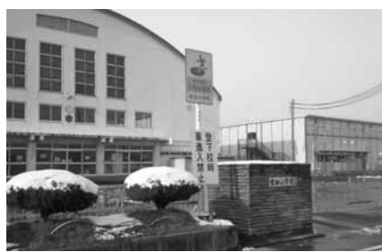
改築が進む吉田小学校
