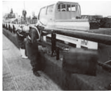
佐渡橋の防護策工事
