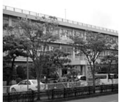
普通教室の冷房が設置されている分水小学校
