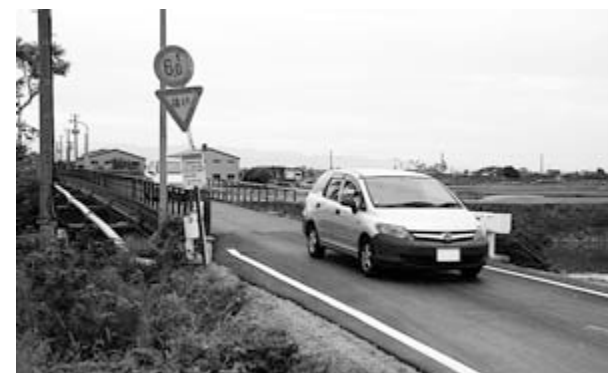
分水熊森地区の信濃川にかかる万盛橋
