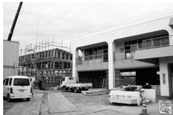
建設が進む「燕南こども園」
