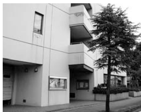
公共施設にもLED化を(燕図書館)
