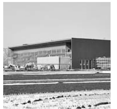
建設中の新庁舎
