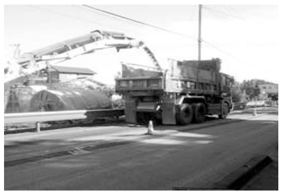
幹線道路舗装工事
