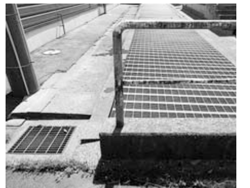
フタがされている状態の排水路
