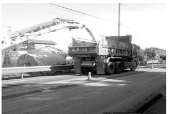
幹線道路舗装工事
