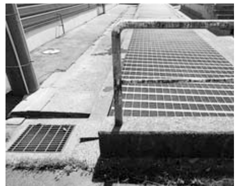
フタがされている状態の排水路
