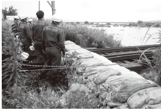
平成 23 年 7 月 30 日 洪水時の越後線の土のう積み
