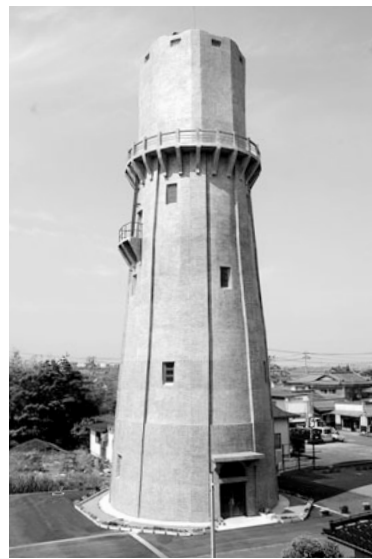
燕市の旧水道事業のシンボルであった水道の塔
