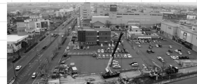
イオン側の排水対策工事
