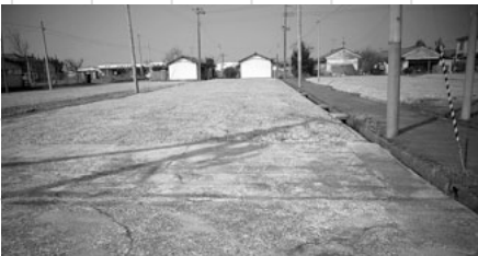
空き地が広がった緑町市営住宅
