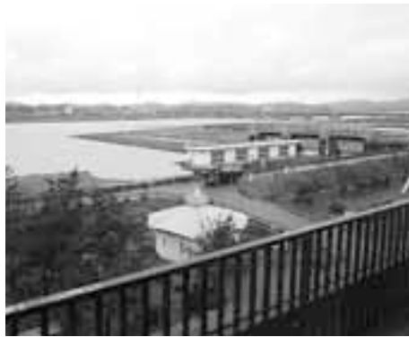
信濃川大河津資料館から見た大河津分水
