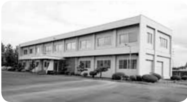
分水浄水場 (昭和49年建設)
