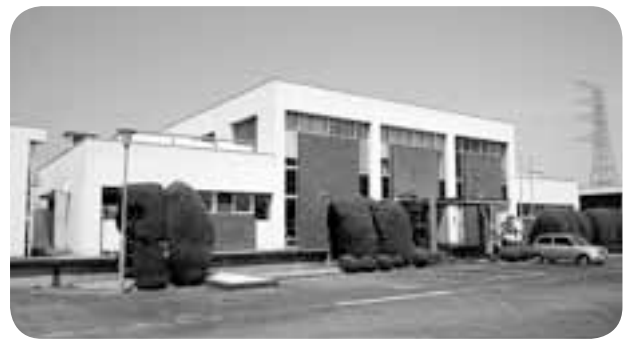
吉田浄水場 (昭和46年建設)
