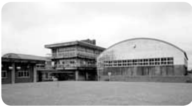
道金浄水場 (昭和39年建設)
