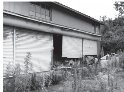
特定空き家に至らない空き家
