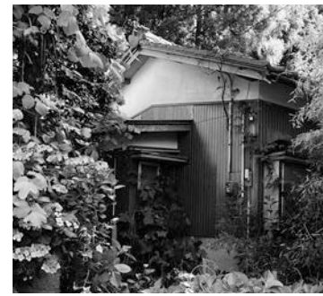
管理不全の空き家
