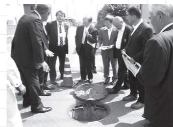
公共下水の改修工事現場を視察
