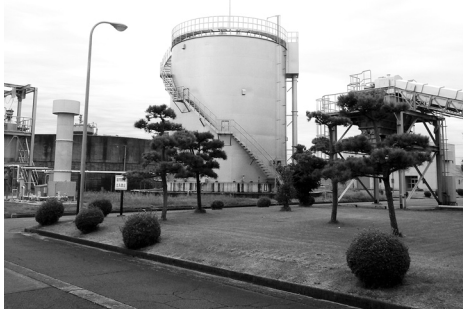
工事が終了した下水終末処理場貯留タンク
