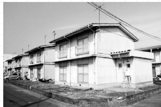
空き室となっている市営桃山団地内の住宅
