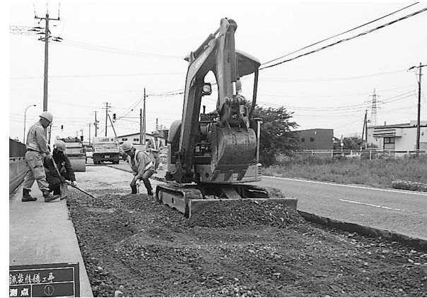
道路舗装修繕工事
