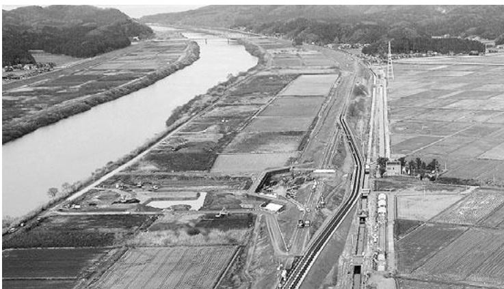
大河津分水路右岸堤防強化工事
