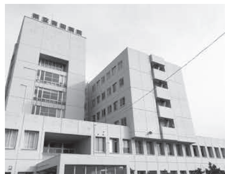
早急な改修が必要な県立吉田病院
