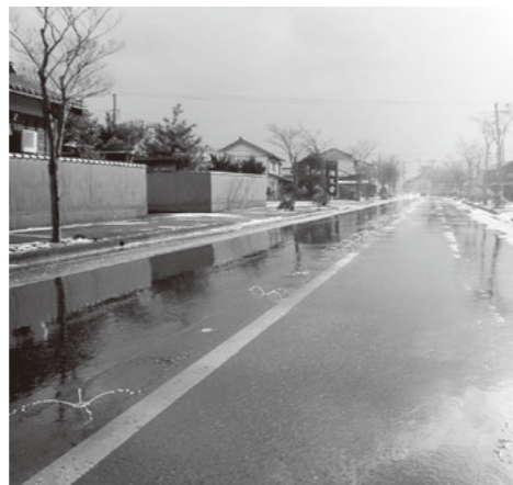
消雪パイプ機能にも限界がある
